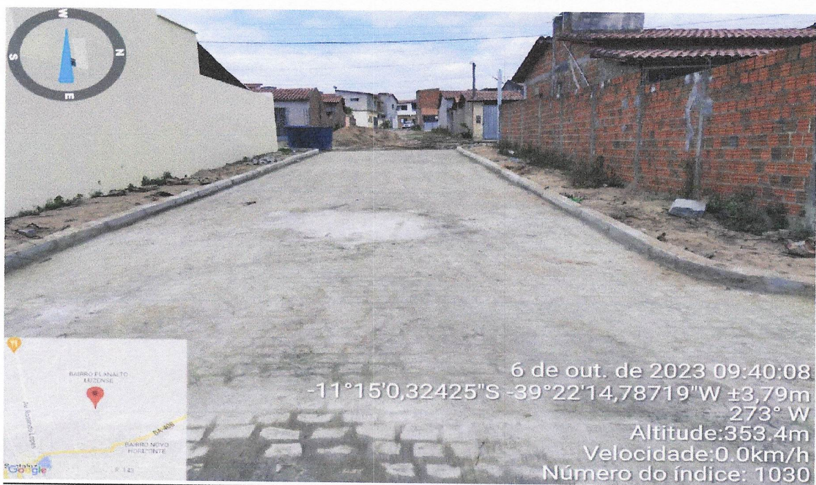
Execução de Pavimentação do Cantinho da saude Rua 07
