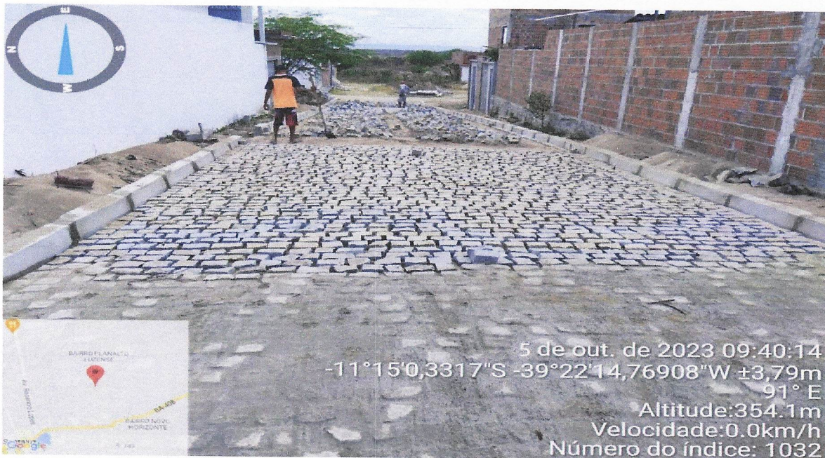
Execução de Pavimentação do Cantinho da saude Rua 07
