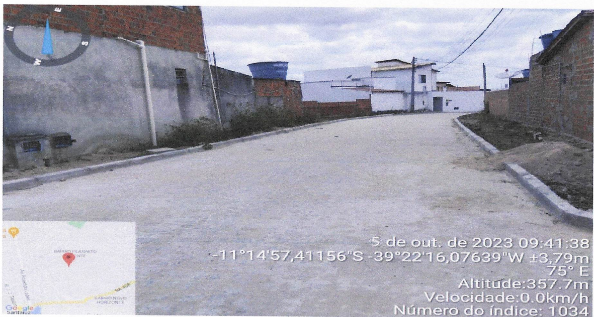
Execução de Pavimentação da Cantinho da saude Rua 02
